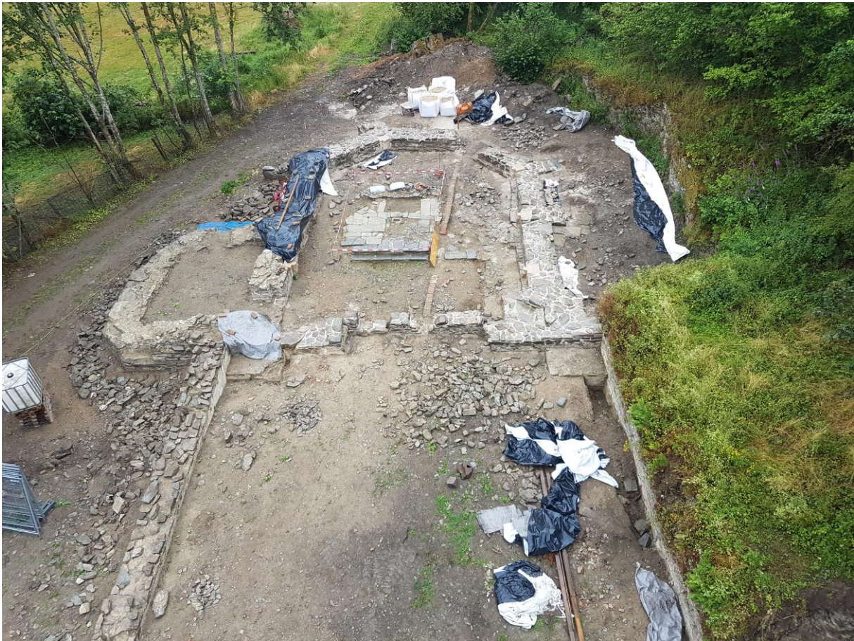
Blick von Westen auf das Grabungsgelände während der Sanierungsarbeiten im Juli 2020. © BfB Zeune 2020.
